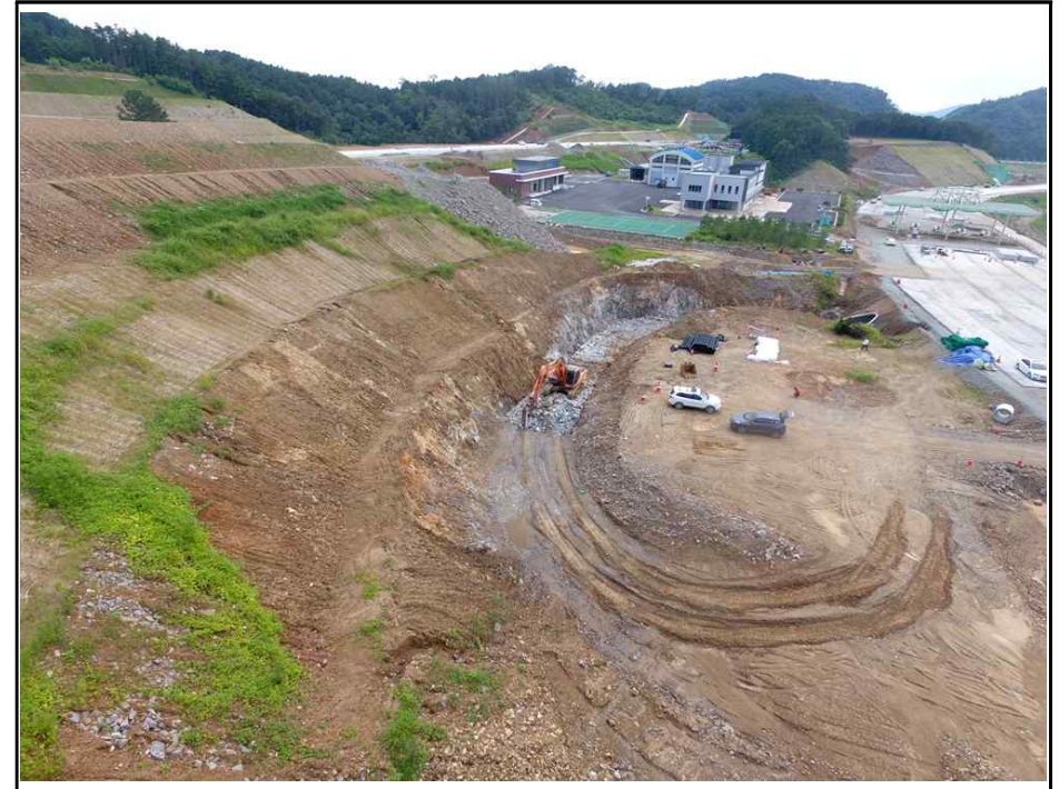
【그림 4】 깎기비탈면 종점부 측면 사진
