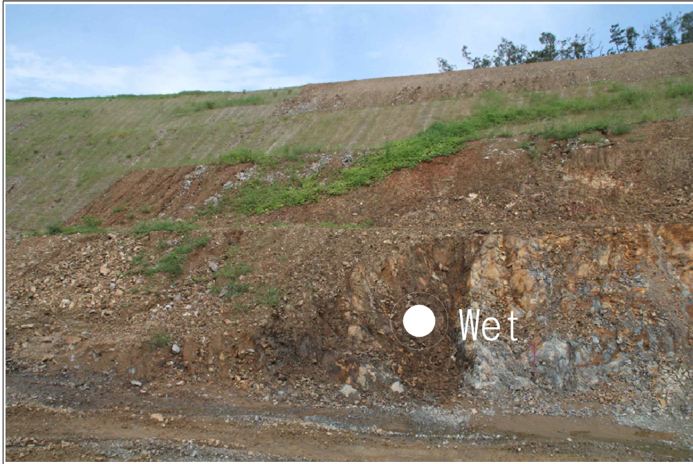
【그림 18】 A 영역 상세사진 (지하수 유출)
