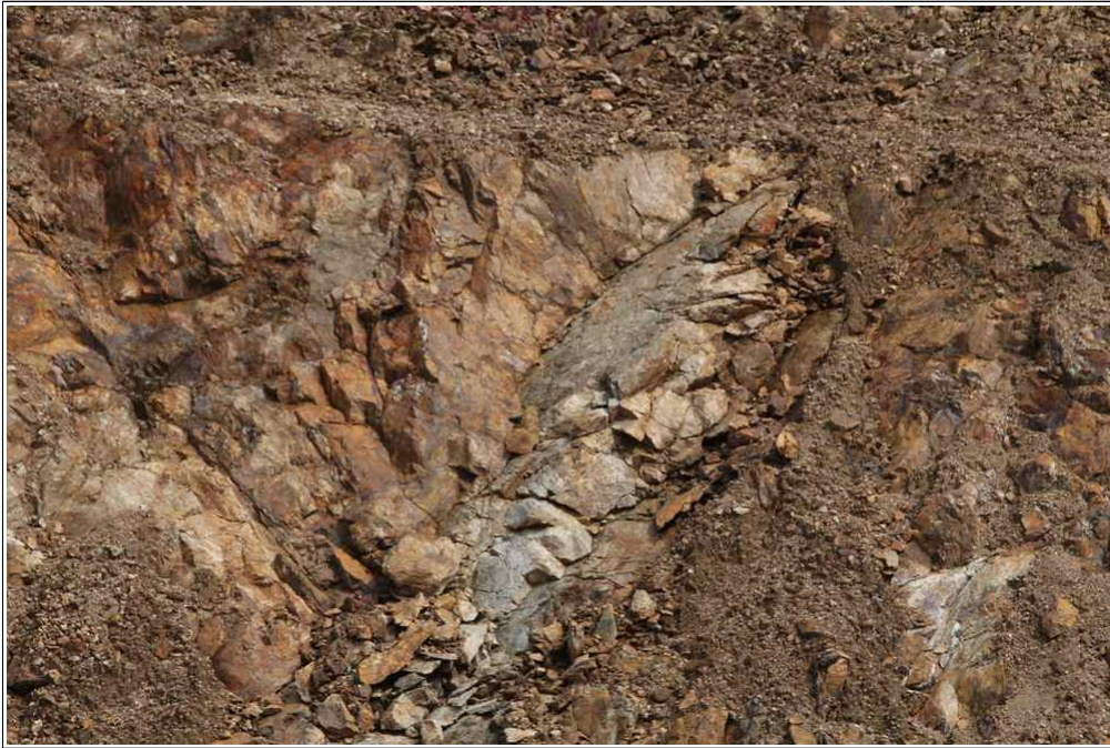
【그림 7】 불연속면 발달 - 썩기파괴 양상
