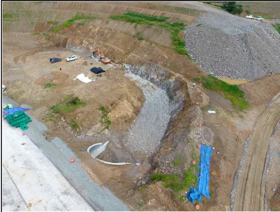
【그림 3】 깎기비탈면 시점부 측면 사진
