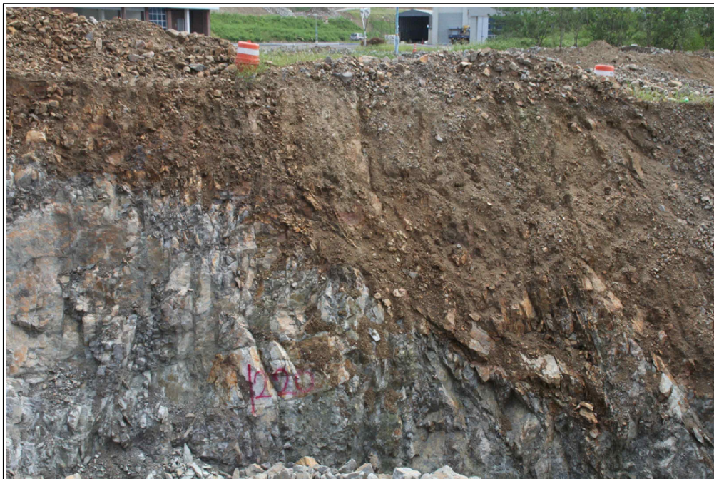
【그림 32】 C 영역 상세사진 (풍화 경계부)
