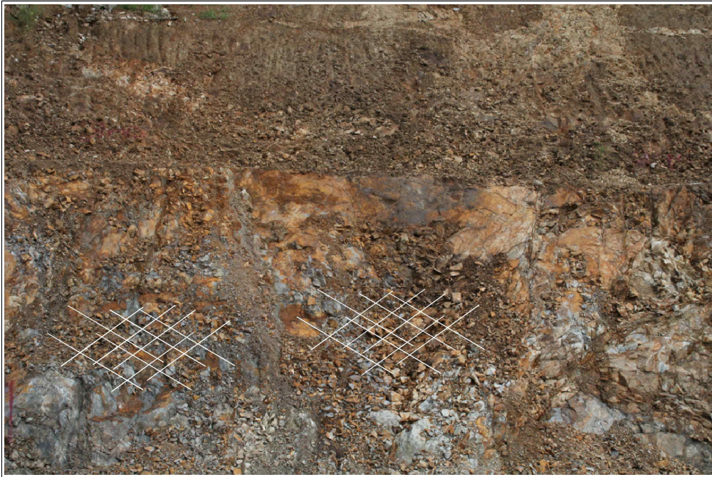
【그림 16】 A 영역 상세사진 (세편화된 암석)
