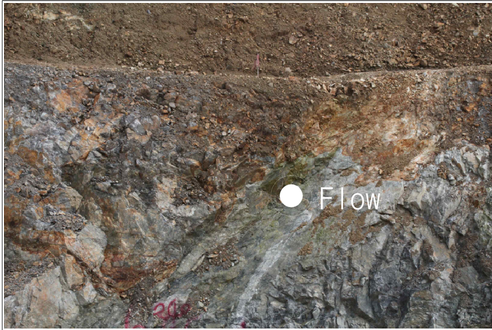
【그림 26】 B 영역 상세사진 (지하수 유출)
