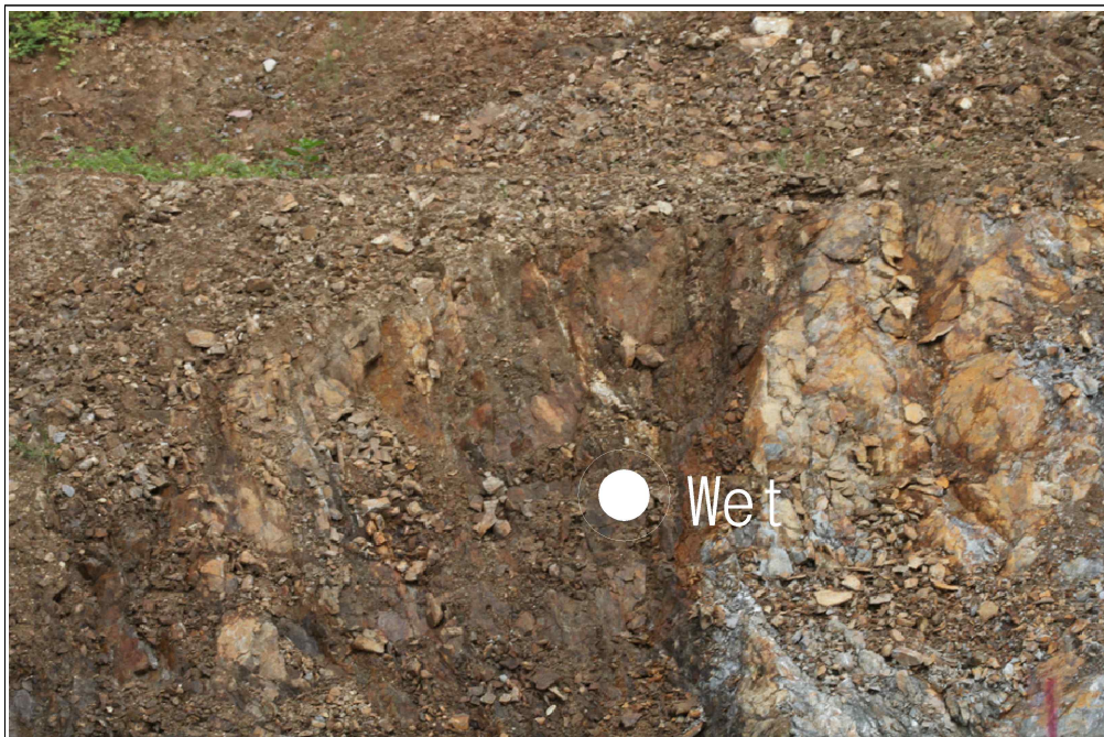
【그림 19】 A 영역 상세사진 (지하수 유출)
